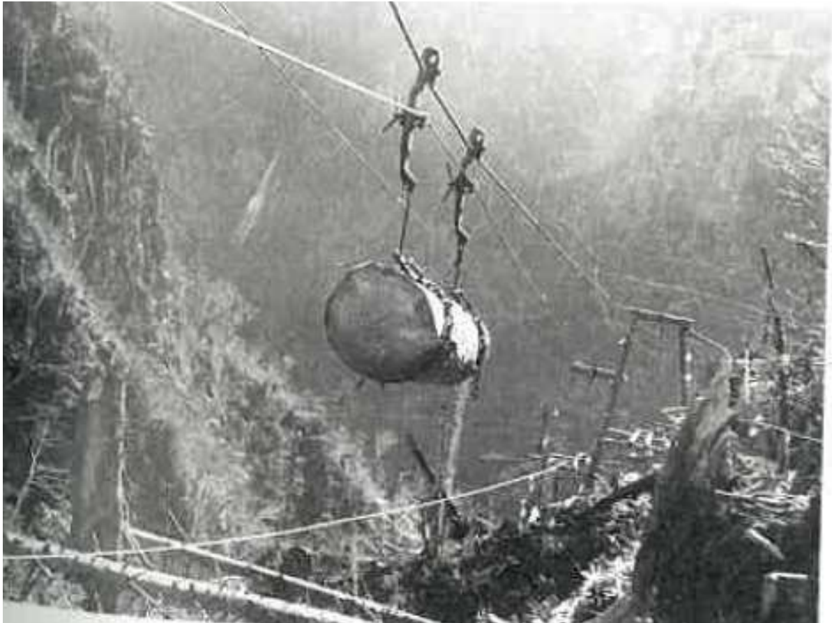
現在のロープウェイの前身である貨物索道による倒木運搬 (写真提供:一般社団法人日本森林技術協会北海道事務所)
